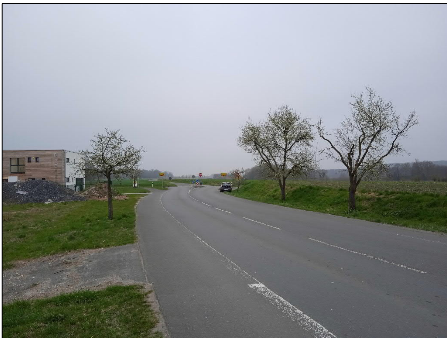
Abbildung 4: Mehrzweckstreifen Rothenberger Straße (Quelle: Aufnahme IPW)
